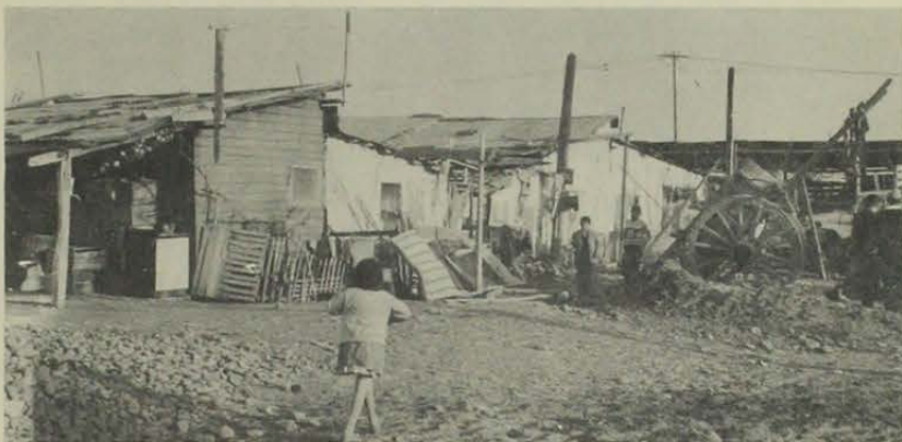
¿Dónde? A orillas de los canales, bajo los cables de alta tensión, junto a los basurales o los puentes, en Antofagasta o Coronel, en Chañaral, en Santiago, en Puerto Montt, el chileno levanta su morada.
