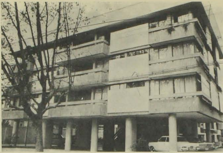
Conjunto Habitacional ubicado en Eleodoro Yáñez y Pedro de Valdivia, proyectado por los arquitectos Carlos Nelra, Carlos Silva y Eduardo Cuevas, que exhibe la particularidad de una planta baja libre destinada a alojar estacionamiento de automóviles en un barrio que indiscutiblemente requiere este servicio.
