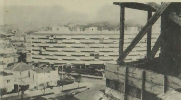
Vista panorámica del Edificio Montecarlo en Viña del Mar, proyectado por los arquitectos Abraham Schapira y Raquel Benavente, cuya fachada se caracteriza por el acierto en el tejido que se logra con el juego de los balcones.
