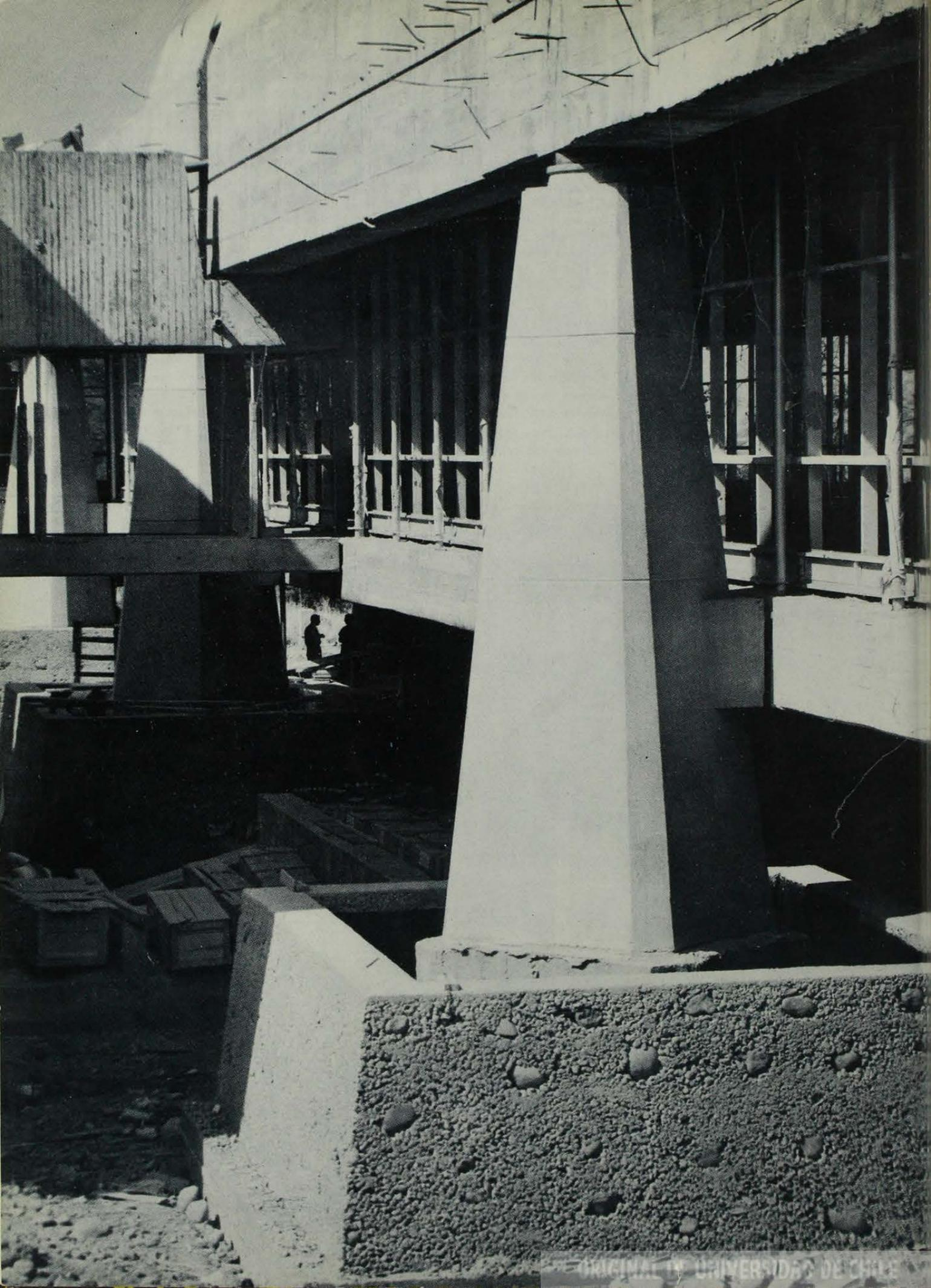
sidente de la mesa, de los observadores y del público. Su doble manto, en espiral, asegura su estabilidad y rigidez y brinda apoyo a las vigas radiales del piso y a los altillos de los traductores y de la prensa. La rampa exterior que rodea y penetra la estructura hasta su cúspide actúa como el nervio atezador de las delgadas paredes de este edificio.
