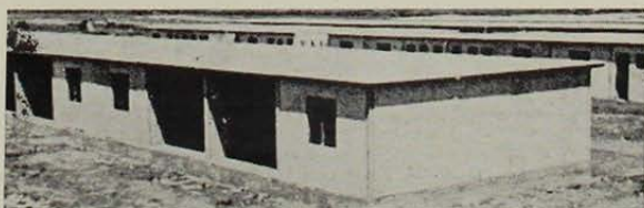
OBRAS GRUESAS TERMINADAS
