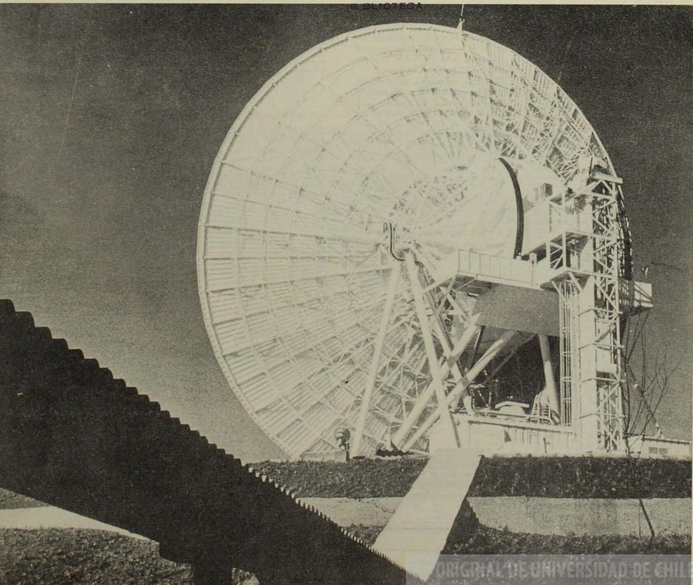
3. Una canaleta aérea registrable conduce todas las conexiones desde el Edificio Central hasta el pie de la antena.
