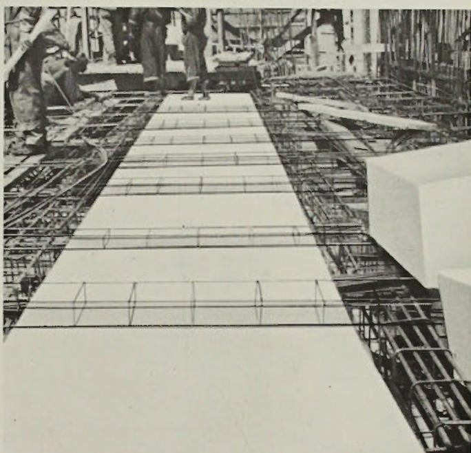
Vistas parciales de los moldajes efectuados con AISLAPOL en el "Edificio de los Trabajadores", en Teatinos esquina Huérfanos, construido por Empresa Constructora Desco.
