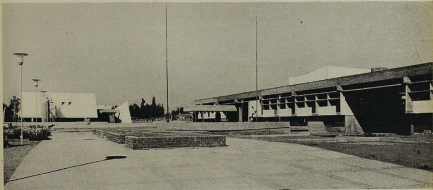
Vista del ingreso - Al fondo el aula magna.
