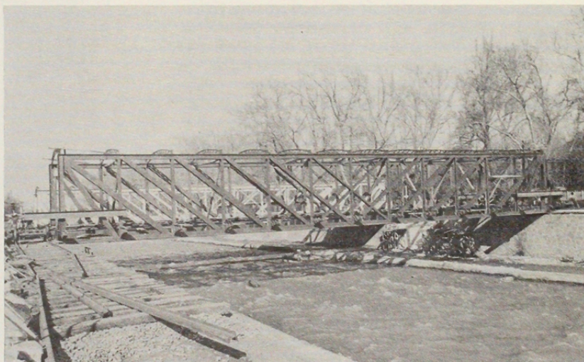
1. Traslado del Puente Loreto. 2. Los Puentes ya funcionando en la actualidad.
