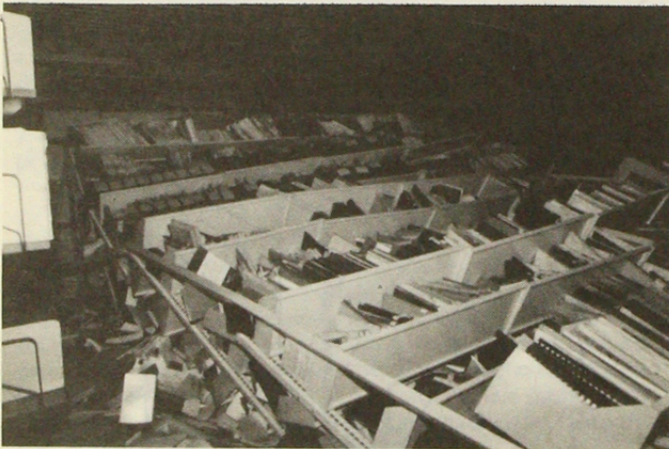
Fig. 2 Colapso de las estanterías de la Biblioteca del Departamento de Ingeniería Civil de la Universidad de Chile. Sismo del 3 de marzo de 1985.
