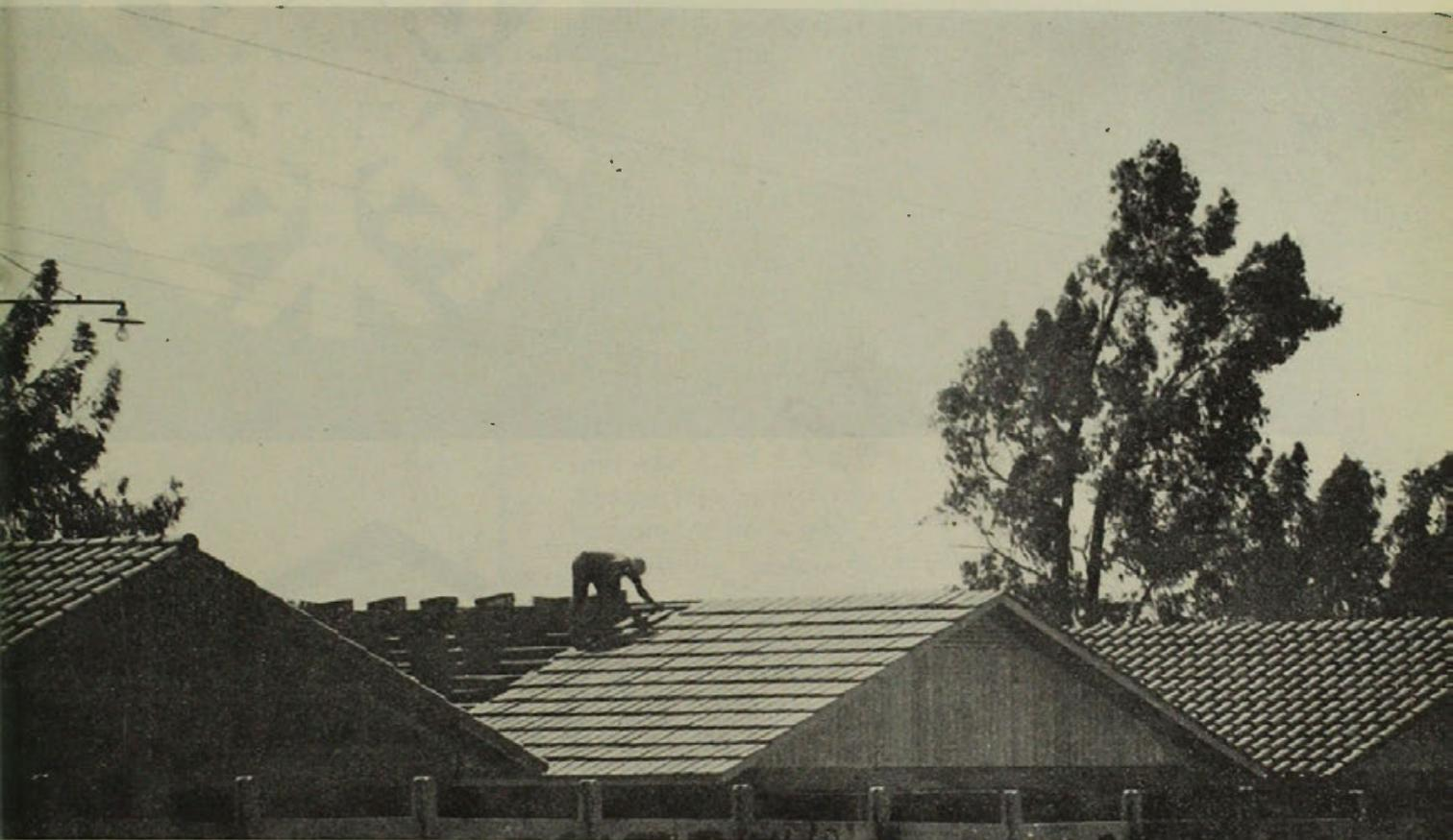
AHORA SE PUEDE AISLANIZAR TANTO UNA CASA COMO UNA POBLACION, RAPIDA Y ECONOMICAMENTE, CON EL MODERNO SISTEMA MECANICO ESPARCIDOR DE AISLAN GRANULADO EN EL ENTRETECHO, A RAZON DE 100 m<sup>2</sup> EN DOS HORAS.
